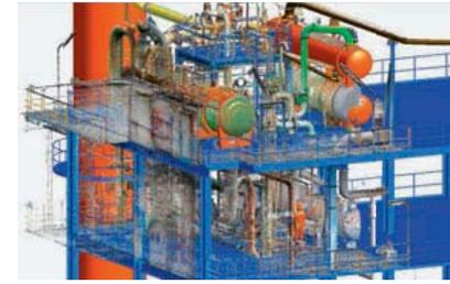
Milliarden von farbigen Scan-Punkten lassen den Ist-Zustand einer Anlage erkennen und dienen zur Unterstützung bei der Positionierung von neuen Rohrleitungen, Stahlbauten sowie Apparaten.
